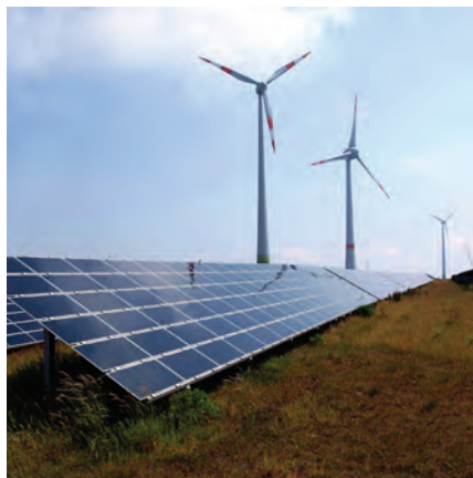
Source: Armin Kübelbeck via Wiki Commons
