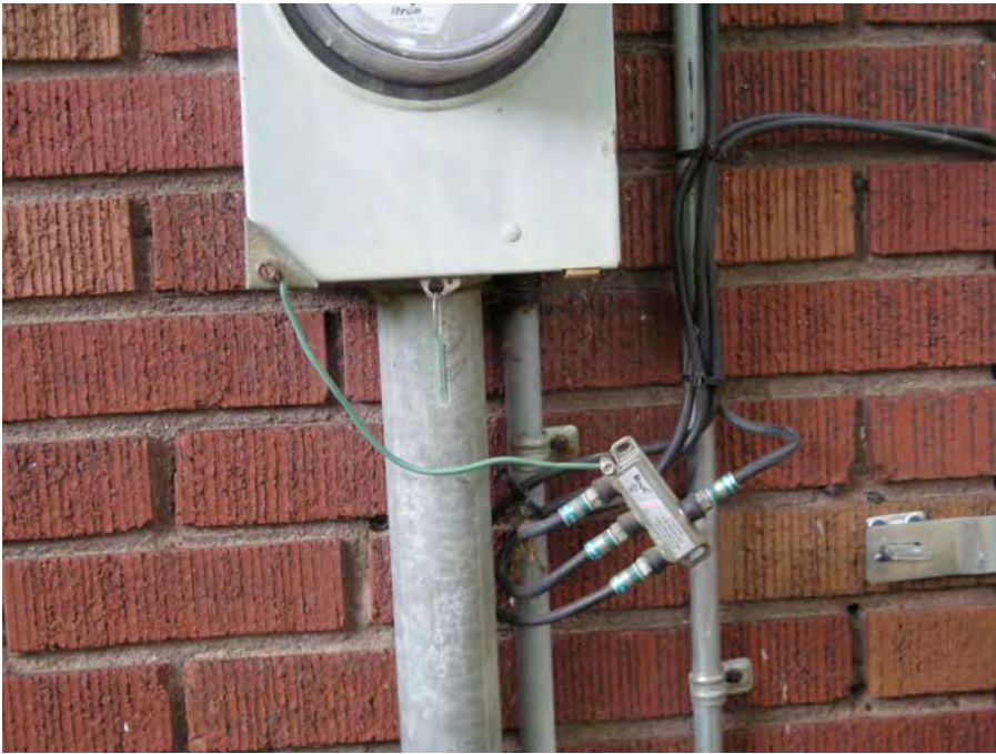
505 W Green; Grounding OK.
